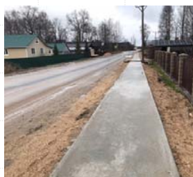
Ремонт дорог и тротуаров - 9 проектов
