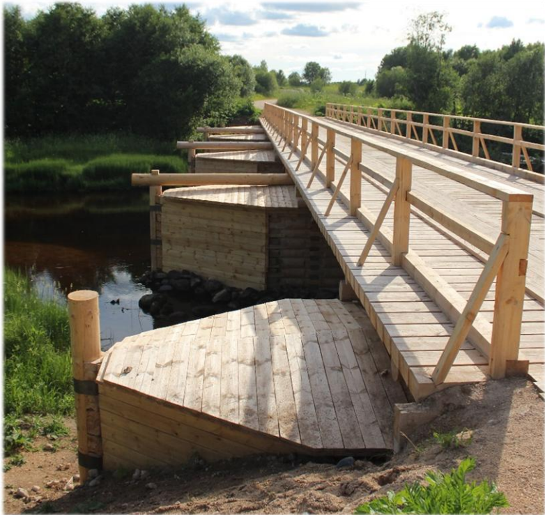
Мост на р. Чурьеге, Каргопольский район
