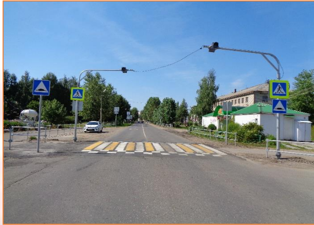
Типовая схема организации дорожного движения на нерегулируемом пешеходном переходе в населенном пункте при двухполосном движении транспортных средств
