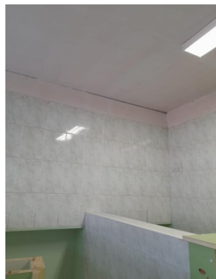
Санитарное помещение ГБУЗ АО «Архангельская клиническая психиатрическая больница» после ремонта
